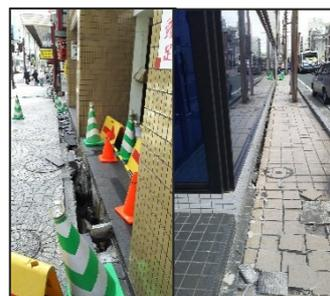
●タイルの剥がれや外壁のクラックなどは多く見られましたが、ビル倒壊やフロア崩壊、傾斜などの大きなダメージを受けているビルは見受けられませんでした。
